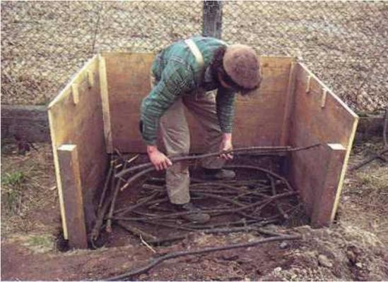
Eine Schicht kleiner Zweige am Boden fördert die Durchlüftung der Mistbeetpackung.
