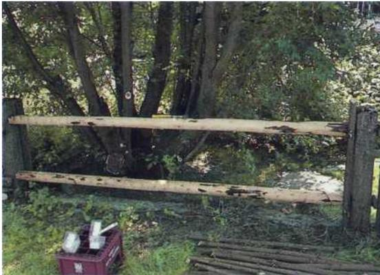
Zum Befestigen sind verzinkte Nägel nötig. Die Hanikel werden falls nötig auf die entsprechende Zaunhöhe zugeschnitten.
