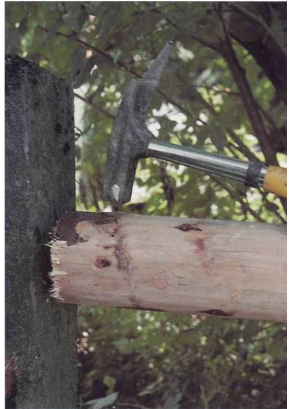
Einfacher ist das Montieren direkt an den Säulen. Die alten Flacheisen werden weiterhin als Halterung verwendet.
