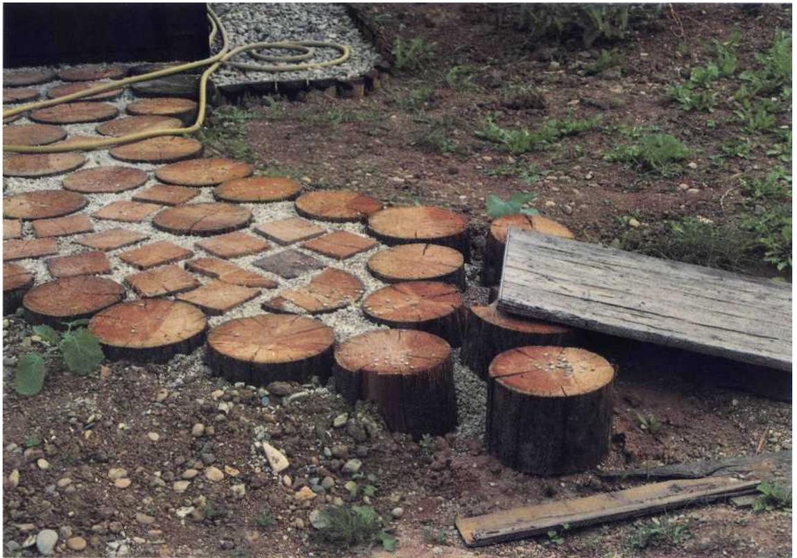
Das Rundholzpflaster ist zur Befestigung kleinerer Flächen bestens geeignet. Einfache Stammabschnitte und Balkenreste finden dabei Verwendung.
