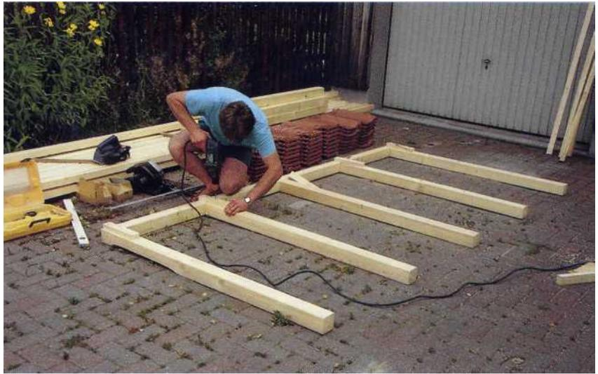
Nach dem Vormontieren kann das erste Rahmenteil aufgerichtet werden.
