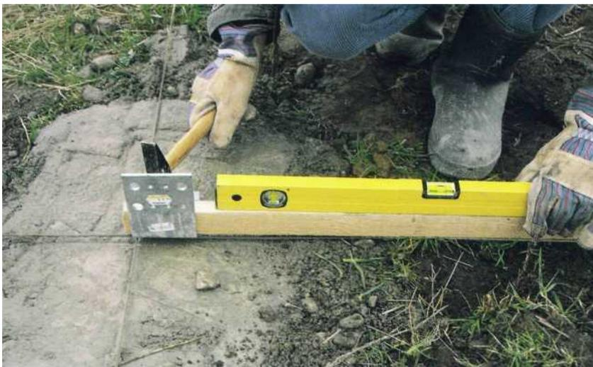
Zwischen den Eckfundamenten genügen stellenweise auch Steine als Auflager für die Balken. Sie werden ebenfalls eingrichtet und in den Beton gedrückt.
