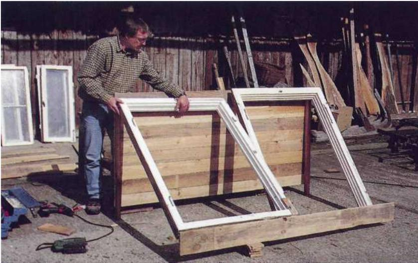
Sobald die Rückwand fertig ist, lässt sich die Frühbeetkonstruktion mit Hilfe der Fensterrahmen und des Frontbretts zur Probe zusammensetzen.
