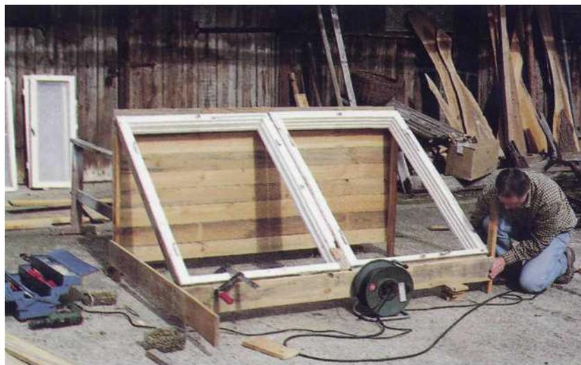
Die Seitenwände werden aus Brettabschnitten gefertigt. Zum Montieren dienen rostfreie Schrauben.
