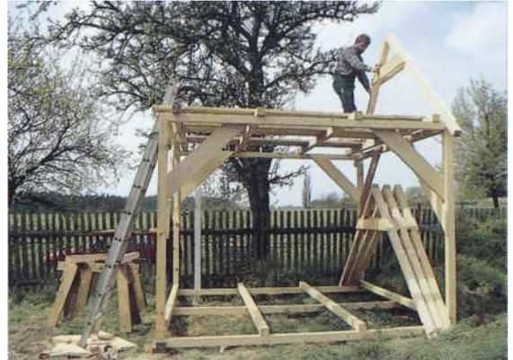
Die Dachsparren werden am Boden vormontiert. Statt der gebräuchlichen Metallteile eignen sich auch Bretter zum Befestigen.
