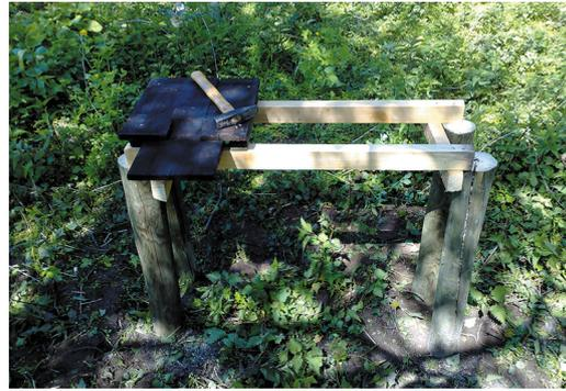
Darauf werden zwei weitere Dachlatten angebracht. Hierauf wird dann der Boden festgenagelt. Der Boden im Bild wurde mit Feuer „imprägniert“.
